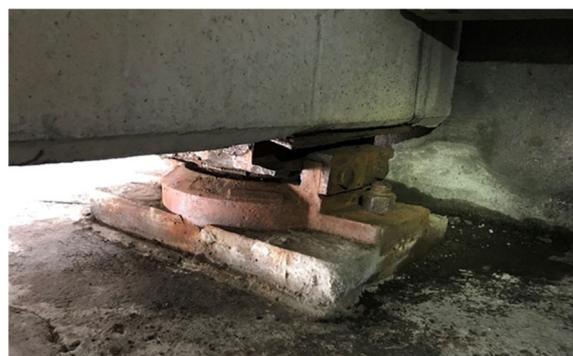
写真-1 橋梁における鋼製の支承の例
