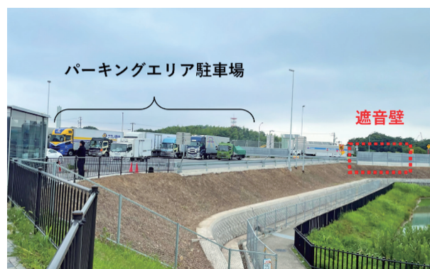
写真-2 PSCを設置する道路の遮音壁
