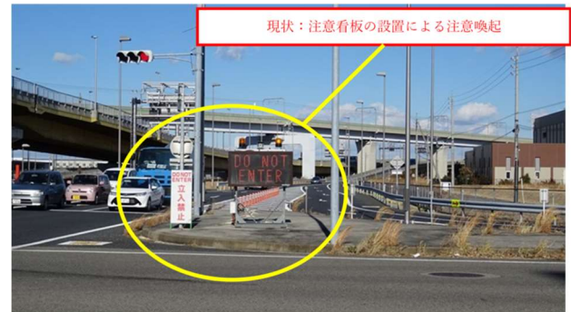
図-1 セントレア東 IC の現況
